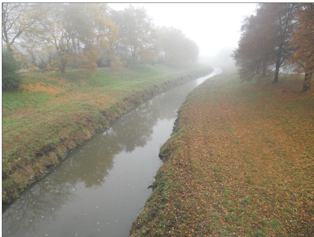
Obr. 26 Pohled na upravené koryto v Horní Moštěnici (foto: R. Možišová, říjen 2013)
