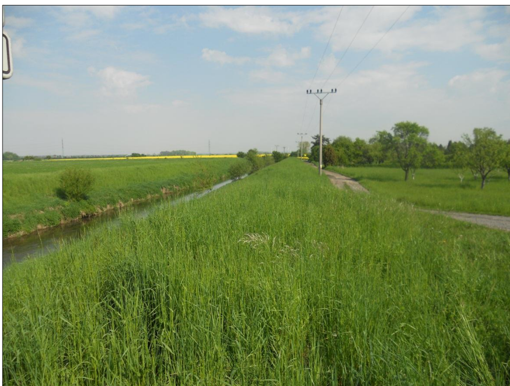
Obr. 28 Místo, kde je navrhovaná hráz v obci Říkovice (foto: R. Možišová, duben 2014)
